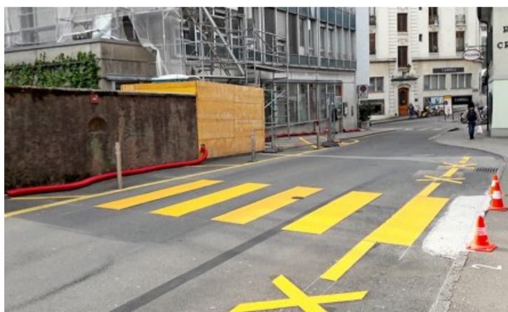
Ce marquage étant destiné à sécuriser la zone de chantier, il devrait être orange pour montrer son caractère temporaire. DR
